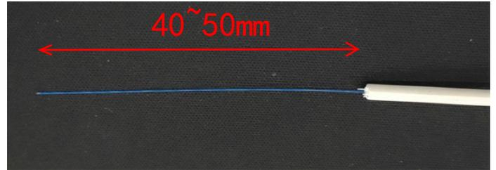
3 插入导轨条，蝶形光缆包层顶住卡位；按下图剥除 0.25mm 涂覆层
